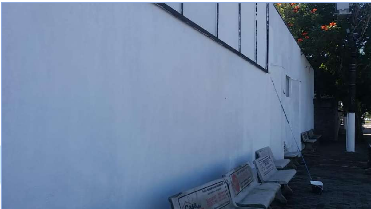
Pintura da parede da área externa - portaria 03
