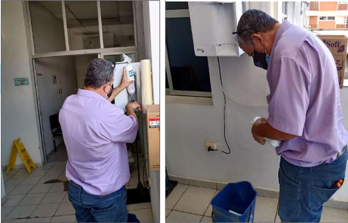
Imagens da troca dos filtros dos bebedouros - 24/09/2019
