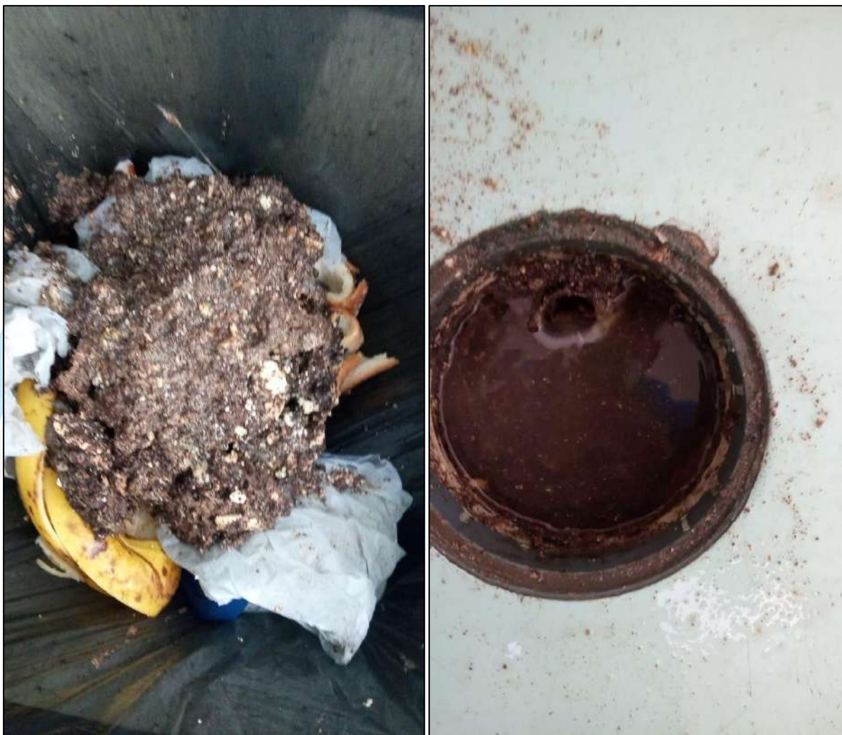
Limpeza de ralos e desobstrução simples
