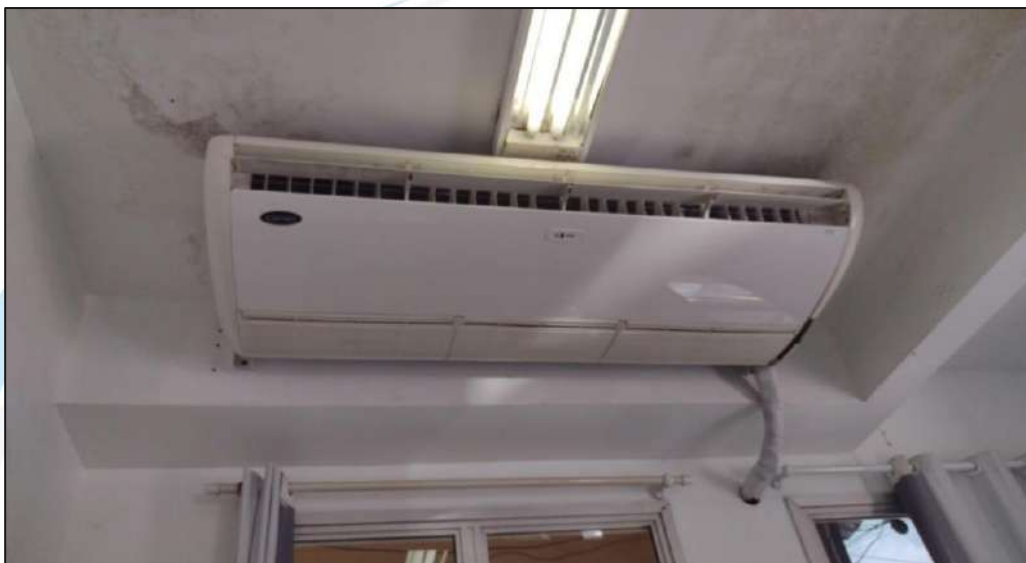
Limpeza preventiva do ar-condicionado da Triagem – 12/01/2021
