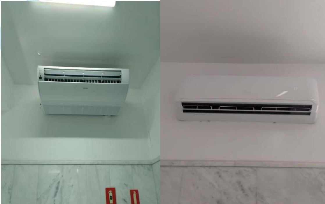
Troca de 04 Aparelhos de Ar-Condicionado
