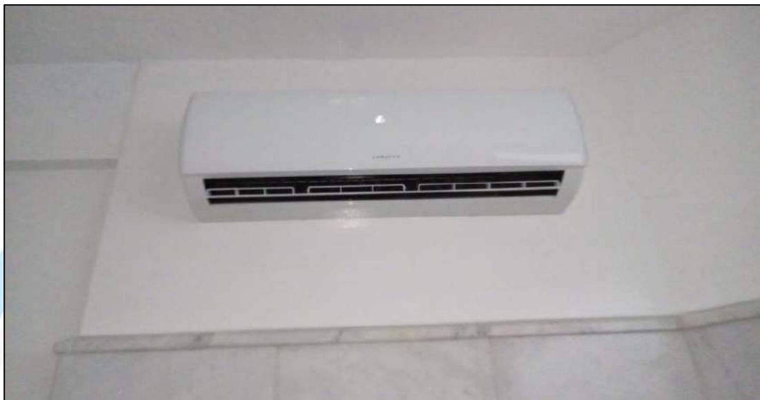
Limpeza semanal do ar-condicionado na sala 2 do Centro Cirúrgico – 11/03/2021
